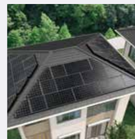
太陽光発電システム
