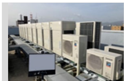
室外機設置工事。既存の基礎架台を流用。室外機サイズ変更の為、設計段階から効率的な配置を計画。
