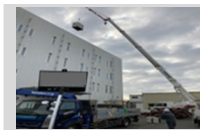
室外機搬入工事。地上駐車場からクレーンで屋上へ。
