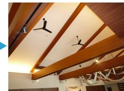
空調効率向上のためシーリングファンを追加で設置。温度ムラの解消と省エネ化
