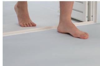
安全に配慮した段差18mmのバリアフリー出入口が標準仕様。ドア有効開口幅も680mmと広々しています。
