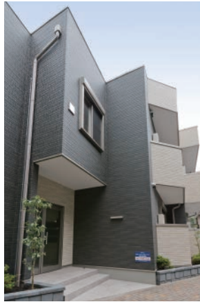
三角形の敷地を有効活用。 斜線制限による桁落ち屋根に葺き 下ろし登り梁仕様で対応した事例。 床面積:658.71㎡ 二階建て
