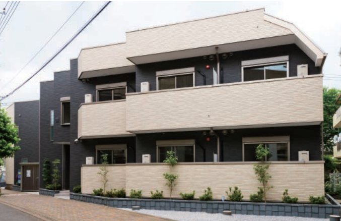
三角形の敷地を有効活用。 斜線制限による桁落ち屋根に葺き 下ろし登り梁仕様で対応した事例。 床面積:658.71㎡ 二階建て
