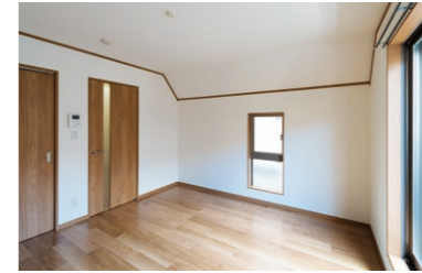
三角形の敷地を有効活用。 斜線制限による桁落ち屋根に葺き 下ろし登り梁仕様で対応した事例。
