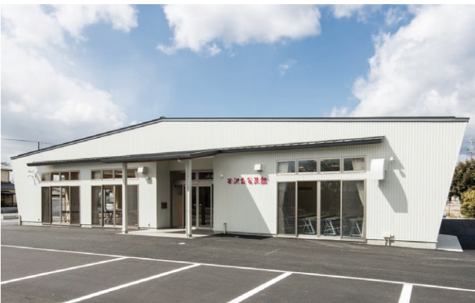
鉄骨に負けない大空間 グランドテクノビームによる10mスパン 4m柱による天井高約4m
