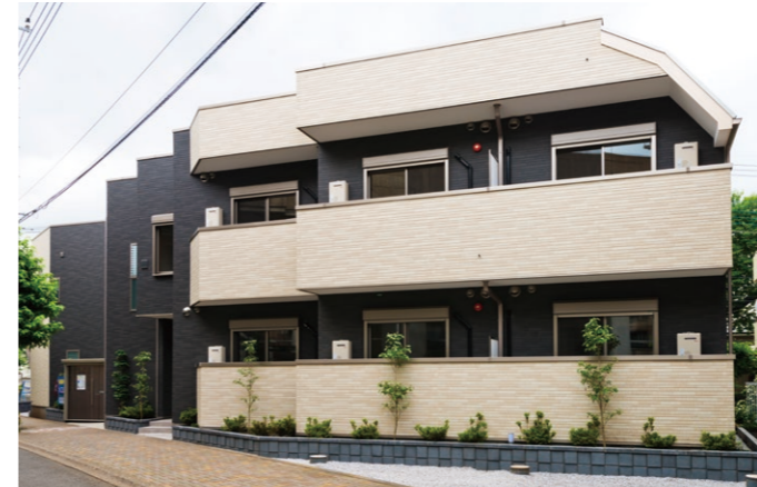
三角形の敷地を有効活用。 斜線制限による桁落ち屋根に葺き 下ろし登り梁仕様で対応した事例。
