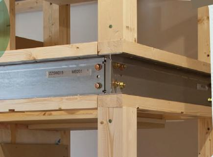
柱なら引っ張り、圧縮、曲げ、めり込みに対する強さ。梁なら曲げ、せん断に対する強さやたわみ量を確認。さらに柱と梁の接合部の安全性を検定します。
