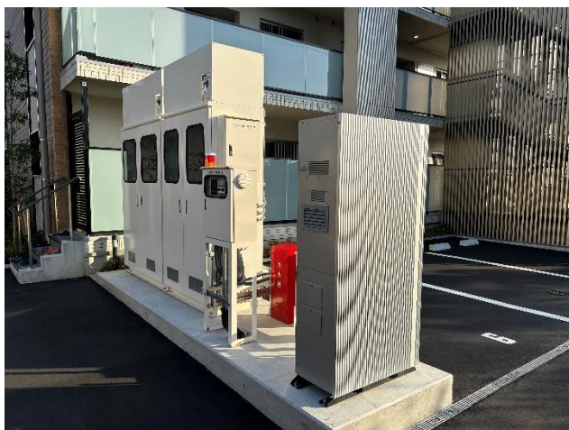
現地設置風景
