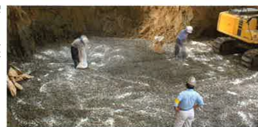
●掘削置換時散布
