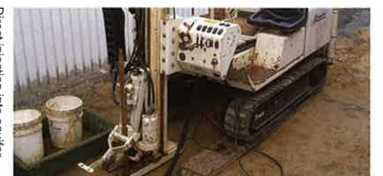
●自動式加圧注入機による直接注入
