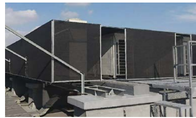
空調室外機への特殊ネット施工
