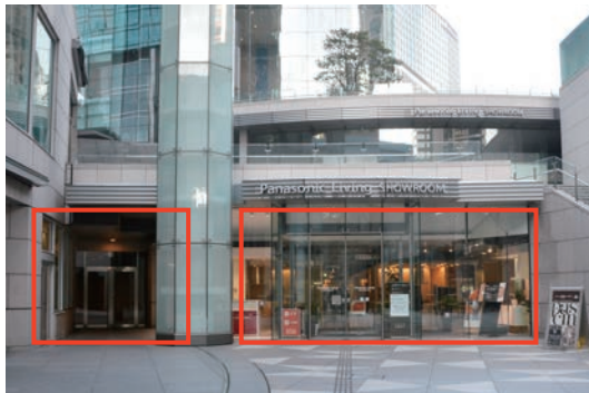
(左) 地下2階駐車場入口 (右) ショウルーム入口
