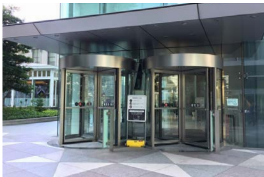
1階回転扉入口
