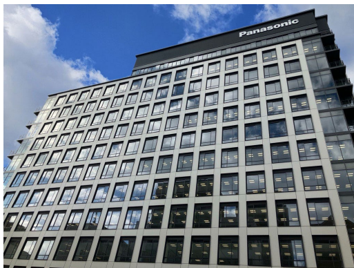
Panasonic XC OSAKA ビル外観
