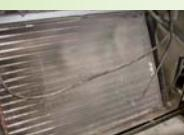
室外機コイルの洗浄を行い能力低下を改善します。   |
