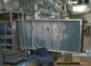
制限のある搬入経路では分割コイルでの施工が可能です。  |
