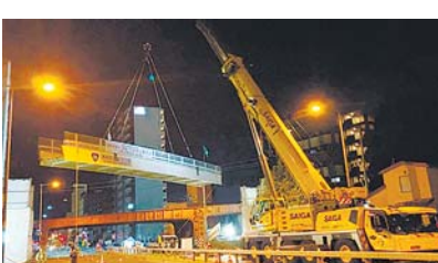
矢田工業＝国道26号千本横断歩道橋撤去工事
