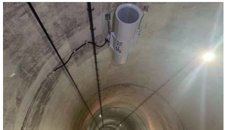
パナソニック環境エンジニアリング西日本支店＝冠山峠道路第2号トンネル排煙設備新設工事
