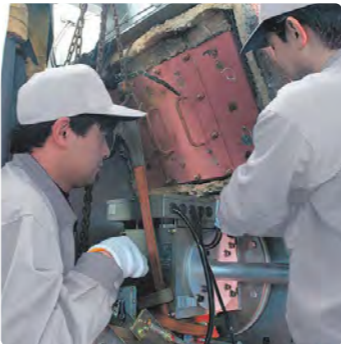
燃焼系部品の交換
