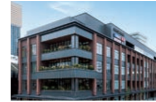
新長崎駅ビル
