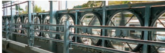
牛舎排気側のインバータ換気扇+電動シャッター
