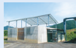
脱臭システム
