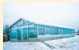
排水処理設備工事(寒冷地仕様)
