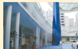
景観細霧設置工事
