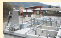
排水処理設備工事
