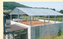
脱臭処理設備工事
