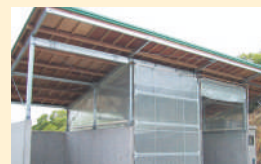
堆肥舎建設工事
