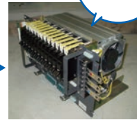
調光盤内器修繕ユニット ユニット単位で取替可能。
