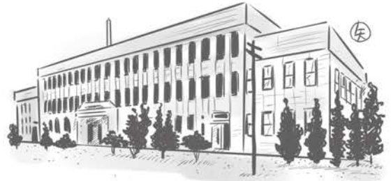
旧高岡電燈本社 (本社会館)(1934) ⊗
