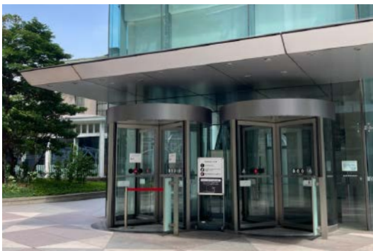
1階回転扉入口
