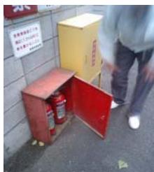
消火器の確認
