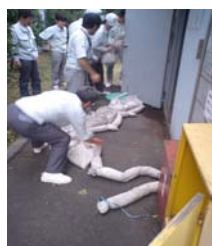
オイルフェンスおよび土嚢の設置
