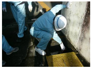
灯油の貯蔵タンクからの漏洩を想定した教育・訓練
